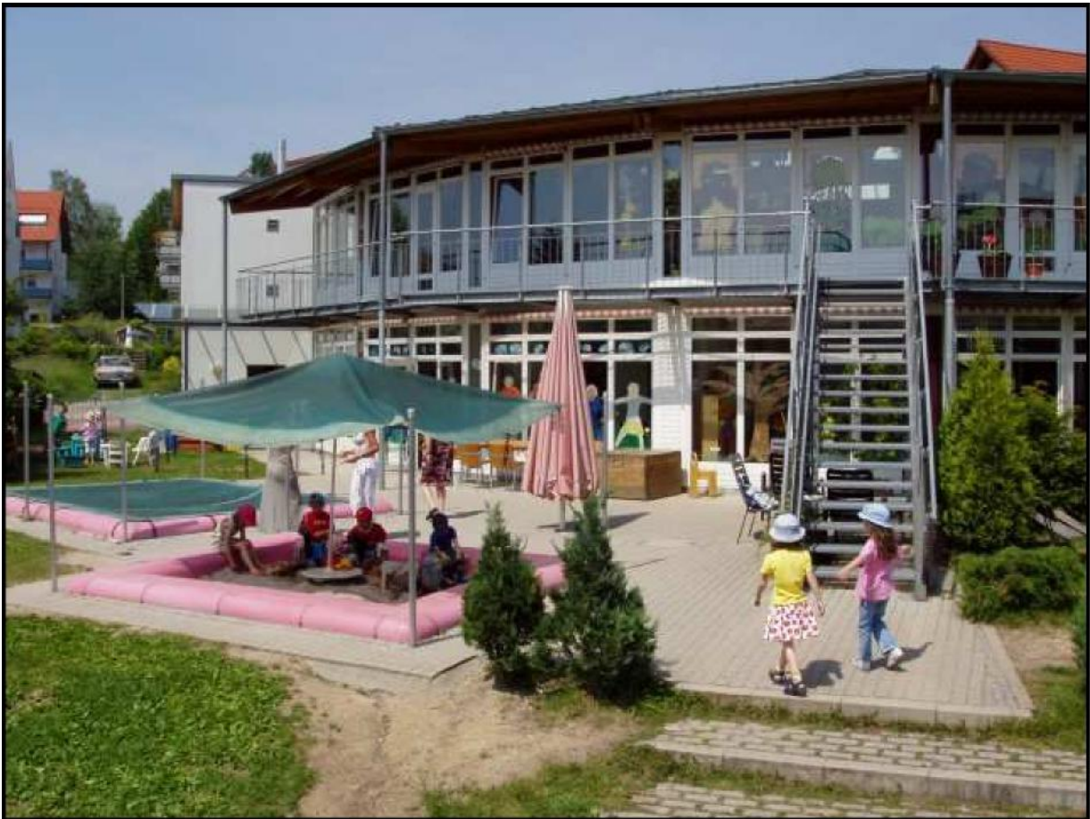
Bild 1: Kindergarten Walzenhalde Außenansicht
